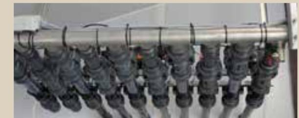
H+L Verteilerbaum mit Stichleitung für die einzelnen Fressbereiche
